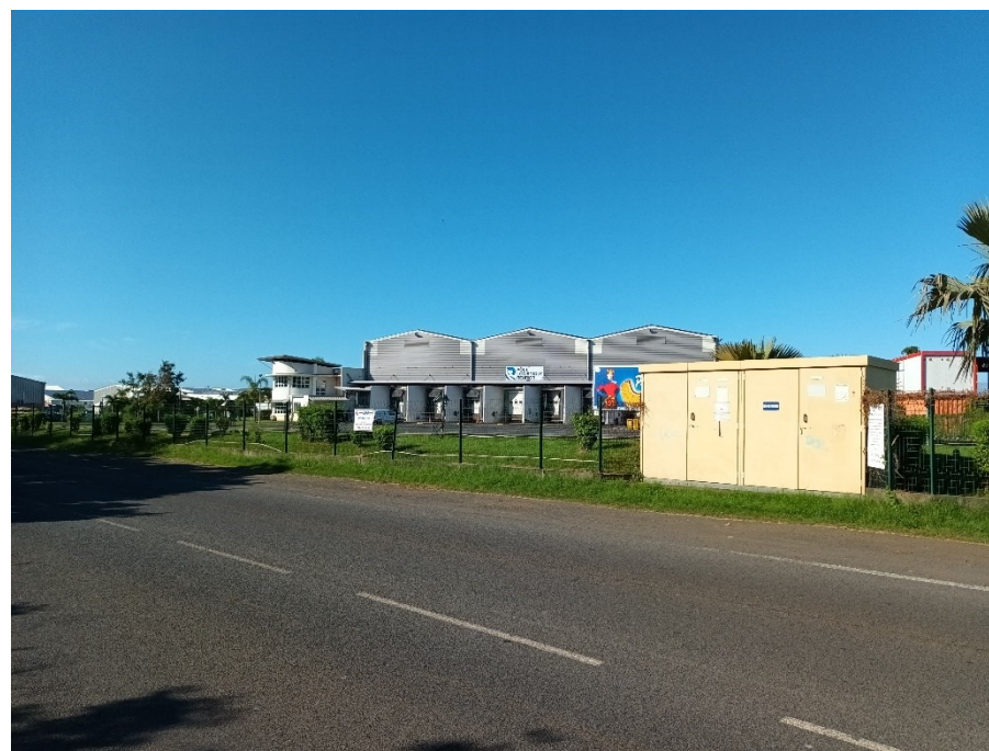
Figure 12 : Photo 8 – Vue des entreprises Pôle logistique Réunion depuis l’avenue Michel Debré
