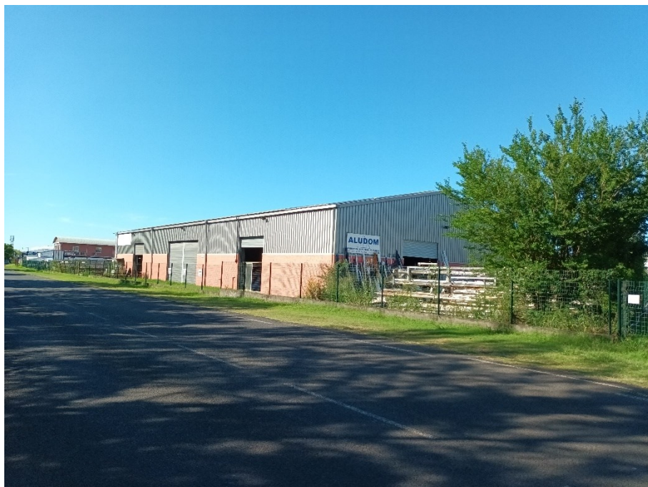
Figure 11 : Photo 7 – Vue des entreprises ALUDOM et JPGRANIT depuis l’avenue Michel Debré
